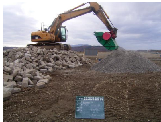
写真一2 再生骨材製造状況
