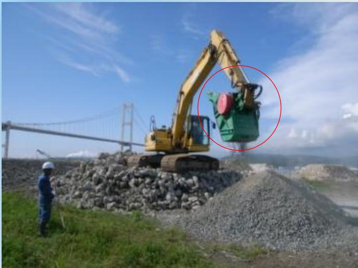
バックホウに装着し、再生骨材を製造
