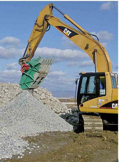
奥尻港物揚場(北) その他工事
