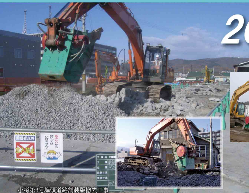
小樽第3号埠頭道路舗装版撤去工事
