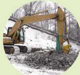
バックホウ(0.8m 3 )に装着 再生栗石製造機作業状況
