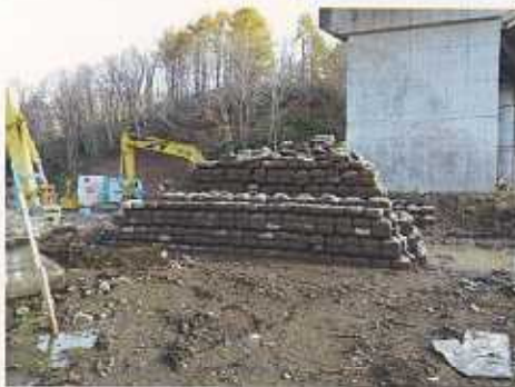
着工前 既存張りブロック撤去
