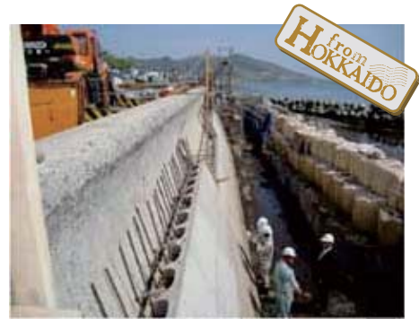
■北海道えりも町(腹付工 施工段数=3段、L=600m)
