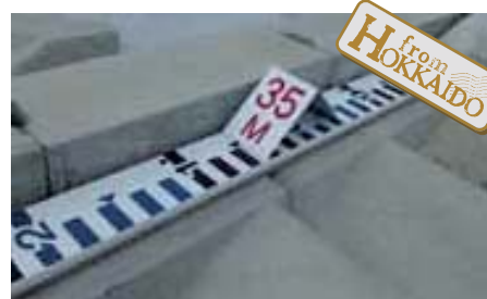
■傾斜部用発泡浮力材内装量水標の設置状況
