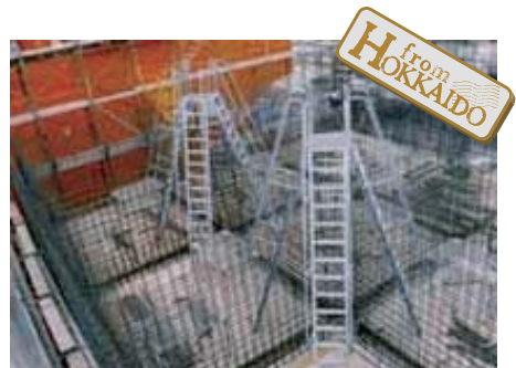
■KSタラップ設置状況
