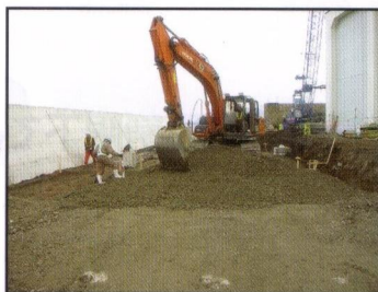
再生材路盤の敷均し作業
