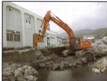
ブレーカーによる取壊し作業
