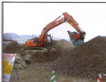
骨材製造アタッチメントによる 骨材再生状況
