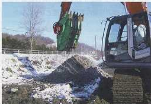
③コンクリート殻を0～40mmに破碎
