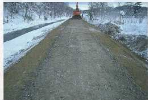
⑥再生骨材による路盤完成
