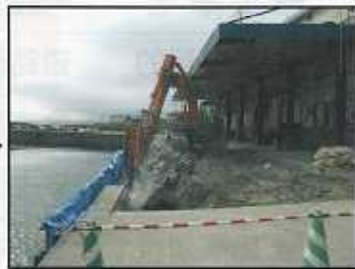
ブレイカーによる取り壊し作業
