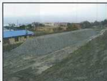
コンクリート殻は骨材に再生された
