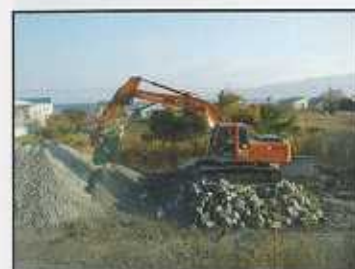
骨材再生アタッチメントによる骨材再生状況
