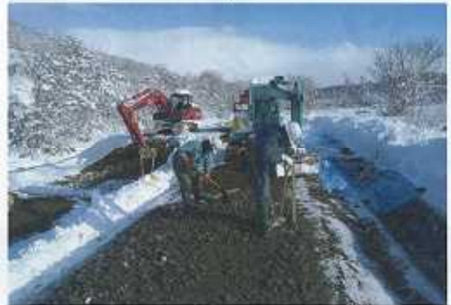
⑤再生骨材の敷き均し作業
