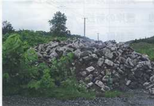
①取水施設の取り壊しで発生したコンクリート殻
