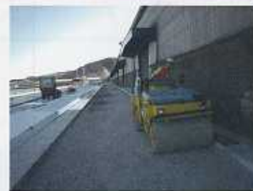
⑤路盤施工状況
