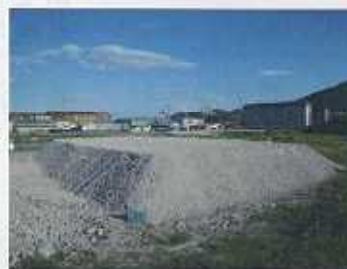
④骨材再生完了
