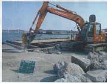
②-1取り壊し状況
