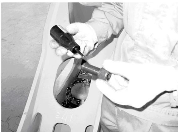
各ボルトのネジ部に低強度ネジロックを塗布する
