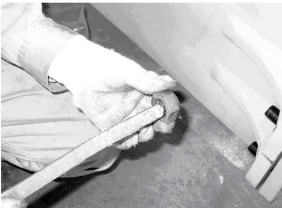
各第2ナットのネジ部にネバーシーズを塗布する
